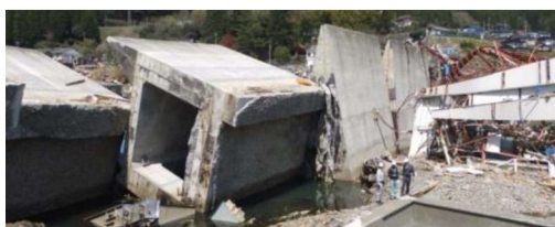
Hình 9. Một đoạn đê sụp đổ trong thảm họa động đất sóng thần năm 2011
