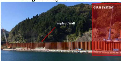
Hình 10. Công trình tường kết cấu Implant ở Iwata – Nhật Bản.
