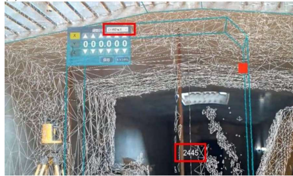
Hình 9. Ứng dụng của GyroEye Holo và thiết bị MR HoloLens trong việc đo kích thước ván khuôn (hình ảnh tham khảo từ tài liệu giới thiệu sản phẩm của công ty Informatix Inc.). a) Dữ liệu CIM của ván khuôn được đưa lên kết cấu thực, kỹ sư thực hiện việc đo kích thước bằng các thao tác di chuyển tay trong môi trường thực tế hỗn hợp và b) Kích thước được đo hiển thị trong môi trường thực tế hỗn hợp.
