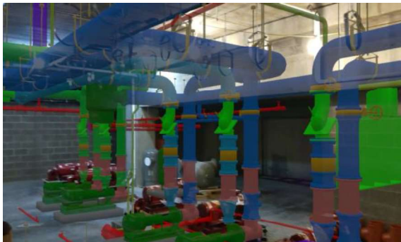
Hình 11. Mô hình 3D của thiết bị được đưa vào thực tế nhờ công nghệ MR (hình ảnh tham khảo từ tài liệu giới thiệu sản phẩm của công ty Visual Live 3D LLC)
