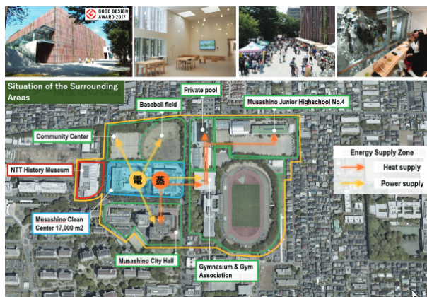
Hình 8. Tổng thể trung tâm thành phố Musashino và một số hình ảnh công trình Musashino Clean Center ở ngoại vi Tokyo, Nhật Bản (Nguồn: Tập đoàn Tư vấn Phát triển Hạ tầng Eight-Japan).
